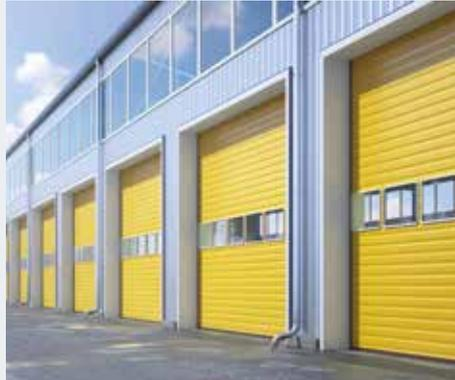
Bardage métallique, porte de garage, tôle ondulée
