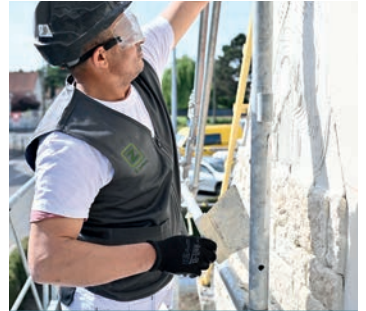
Isolation Thermique par l'Extérieur
