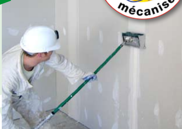
Finition des joints *
